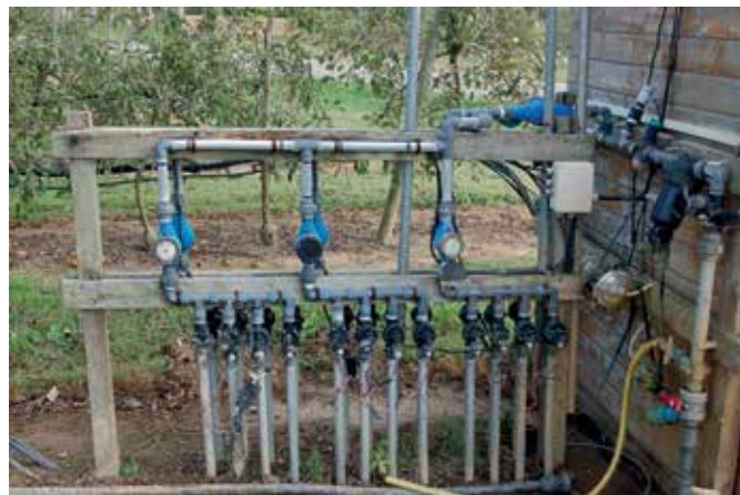
Fragment instalacji do fertygacji sadów. Obecny poziom techniki zapewnia bardzo łatwe i szybkie podanie wody i nawozów nawet w dużych gospodarstwach sadowniczych
